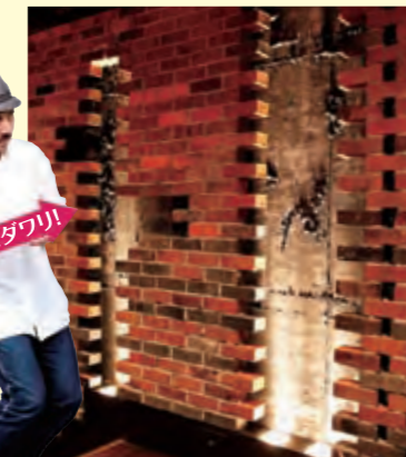
音響効果の改善と劇場のイメージ作り、歴史を感じさせるレンガが2つの役割を果たしている。コンクリート壁と、ところどころ抜けていたり隙間があいている無造作に見えるレンガの積み方も、音の拡散や吸収を緻密に計算してのもの！
